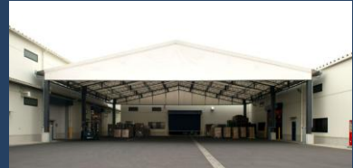
五霞インター倉庫
