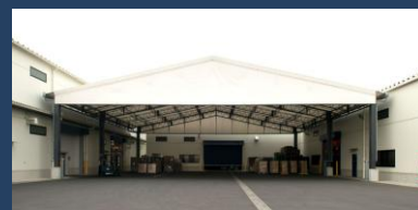
五霞インター倉庫
