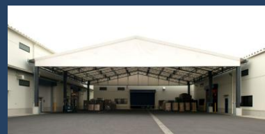
五霞インター倉庫
