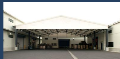
五霞インター倉庫
