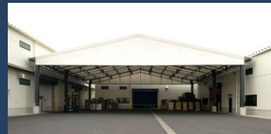
五霞インター倉庫
