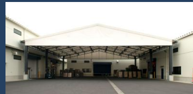
五霞インター倉庫
